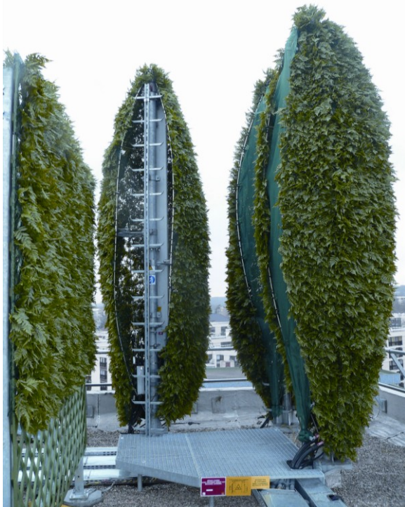
Exemple d'intégration paysagère d'antennes sur le toit de l'hôtel de ville de la commune Le Chesnay (Yvelines, France)
