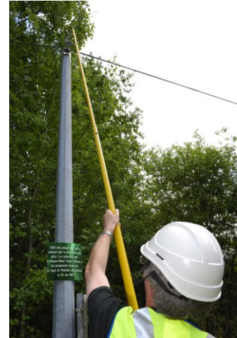
Pose des obturateurs
